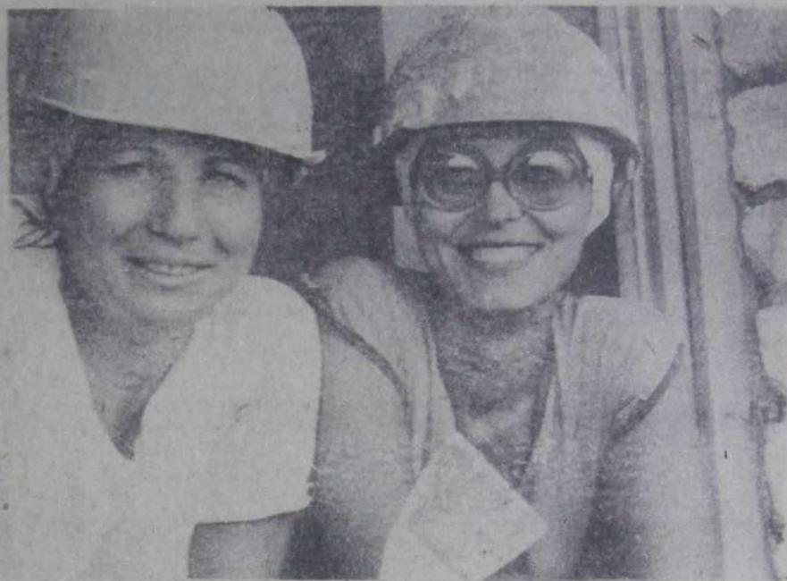
Бригада А. С. Звягинцева из Жилстроя на строительстве жилых домов трудится не первый год. Старательные руки девчат с большой аккуратностью отделяют каждую квартиру, делают все для того, чтобы будущие новоселы от души порадовались своему новому жилищу. С таким настроем работают и А. Иванова, и Н. Новикова (на снимке).
