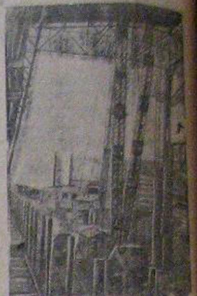
На строительстве Н-ского металлургического завода. Фото И. Мазьского. Фотохроника ТАСС
