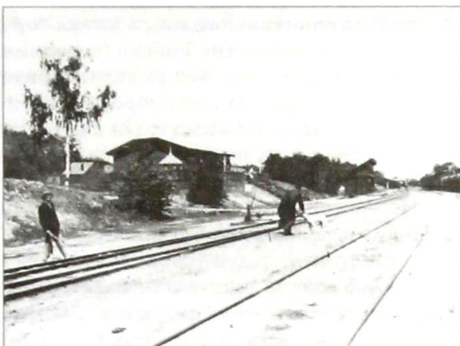
Станция Нефтяная на Увеке
