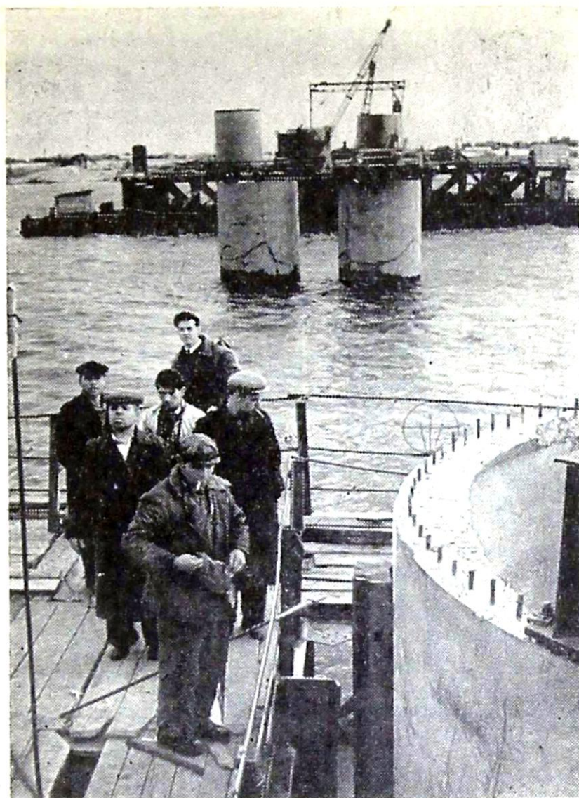
Бескессонное погружение опор. На переднем плане: бригадир Юрий Дорощеев и прораб Захар Степанович Родин.
