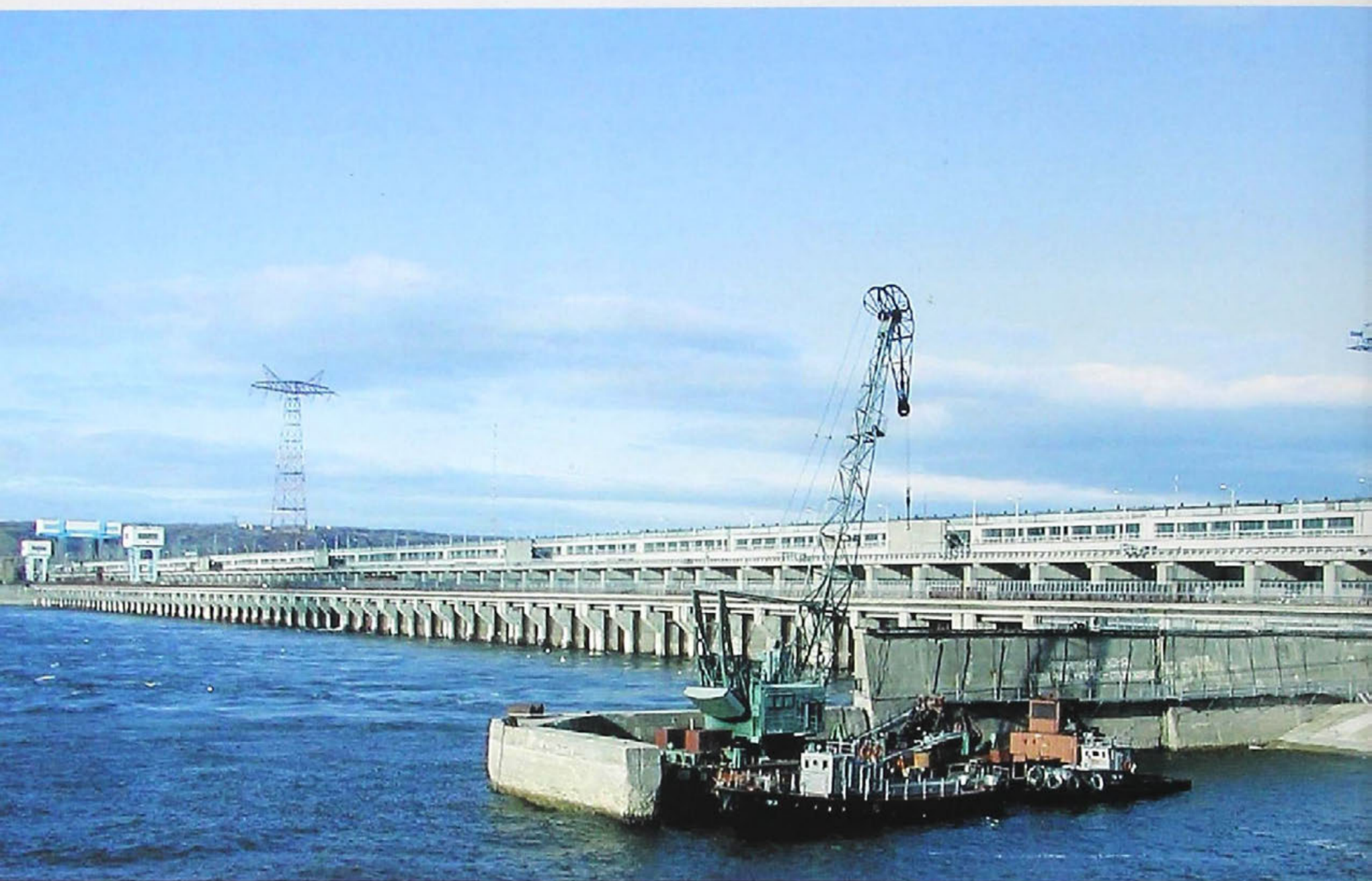
Вид на водосливную плотину Саратовского гидроузла со стороны нижнего бьефа
