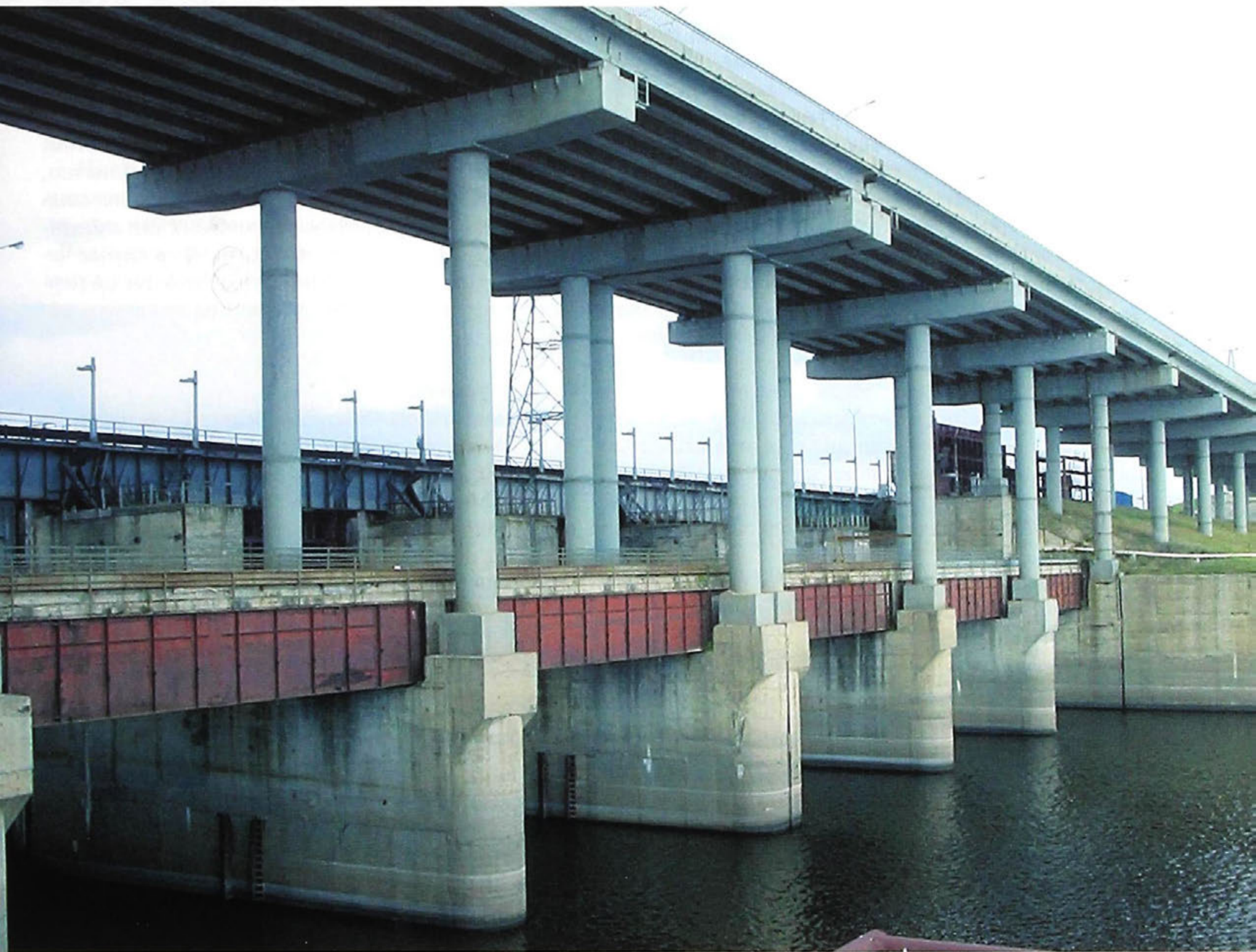
Вид на водосливную плотину Чебоксарской ГЭС
