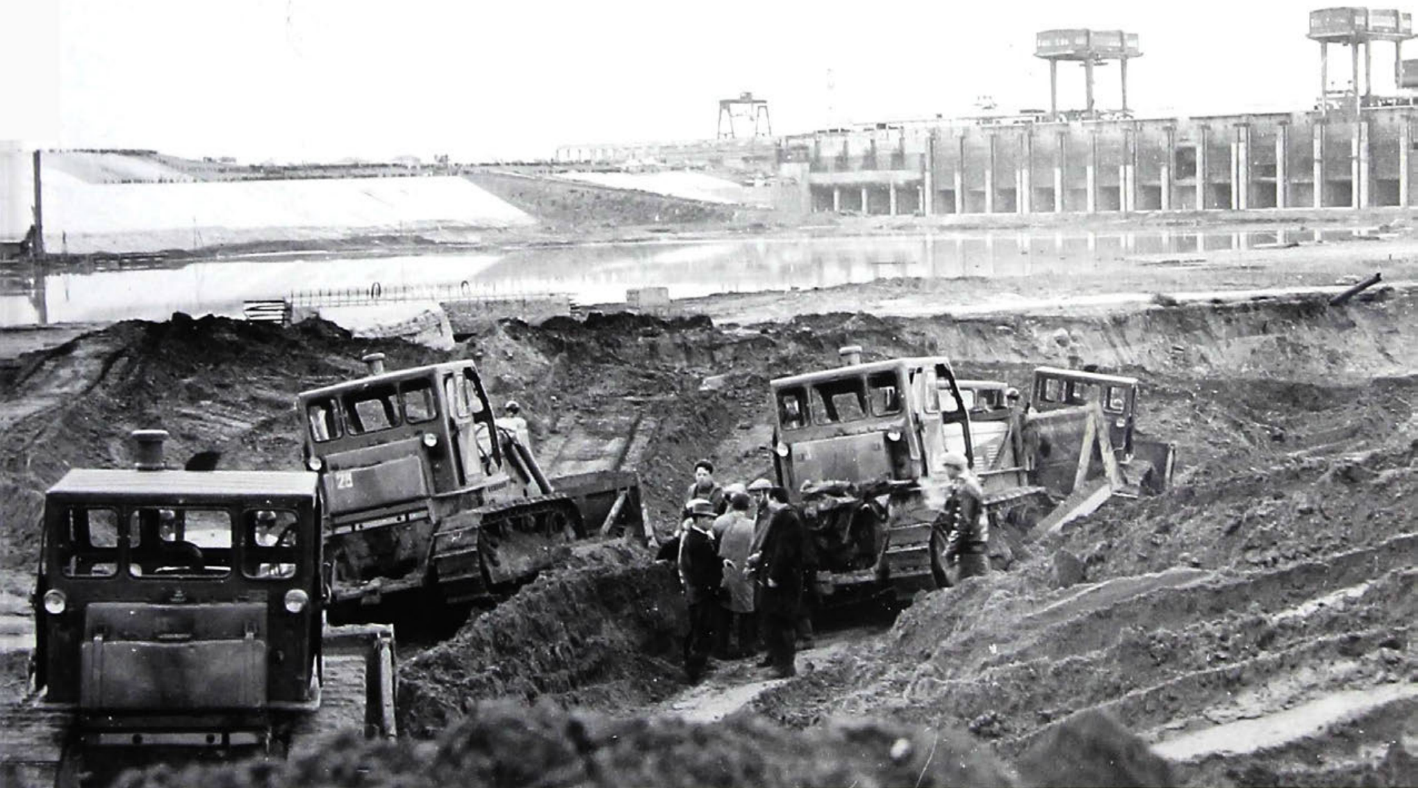
Разборка перемычки под затопление котлована. Вид с верхнего бьефа
