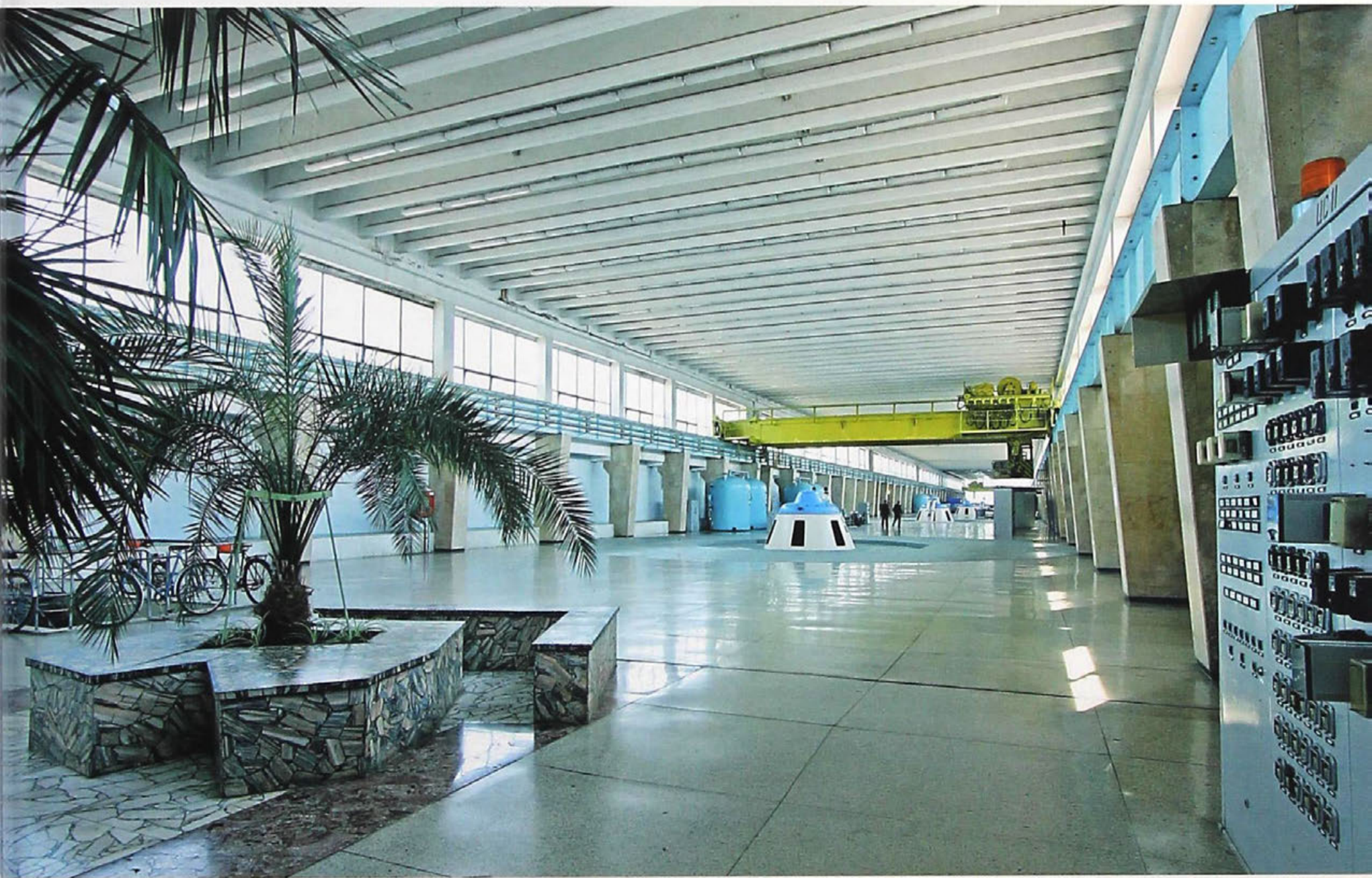
В машинном зале Саратовской ГЭС
