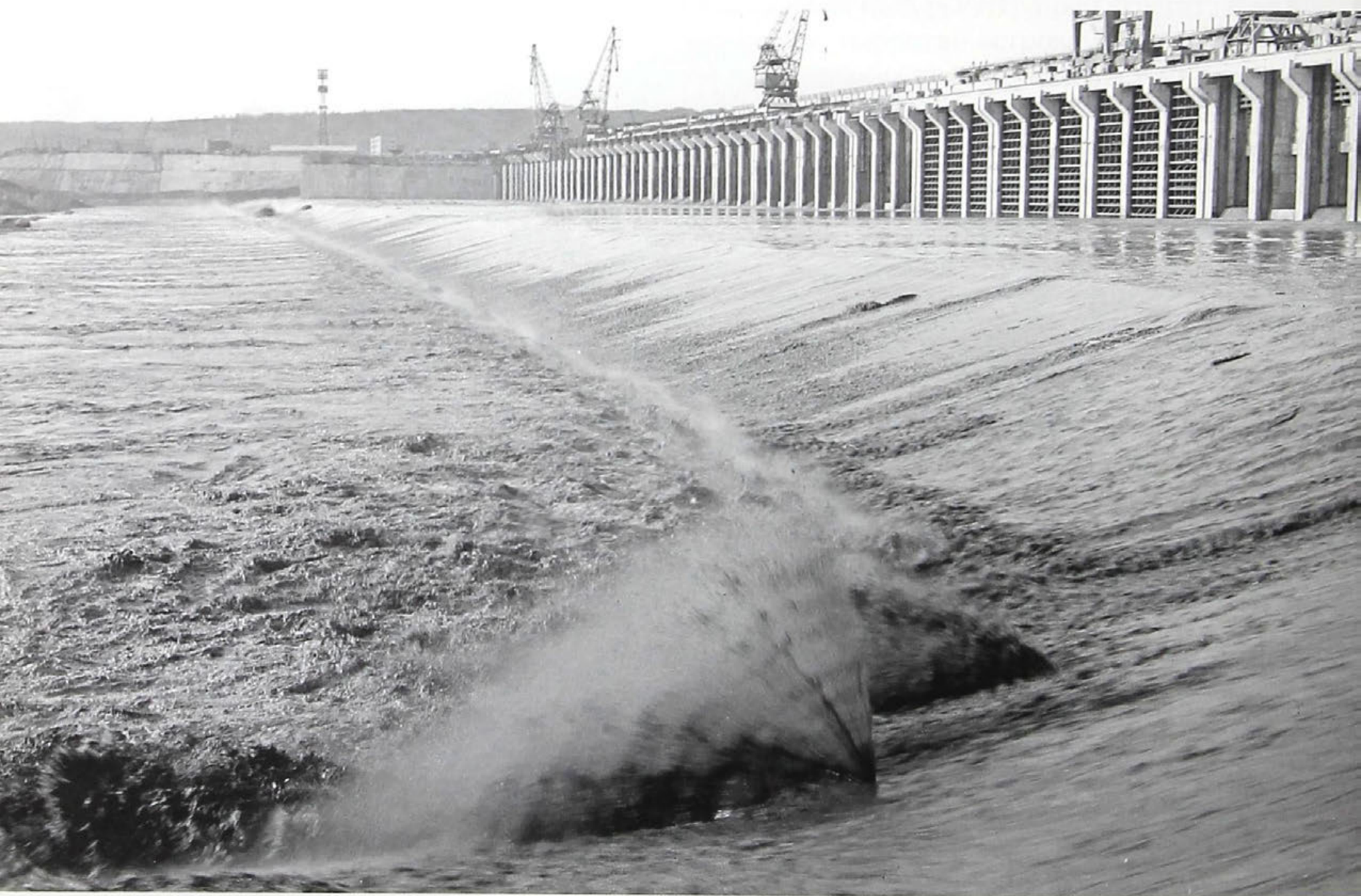
Затопление котлована. Октябрь 1967 года
