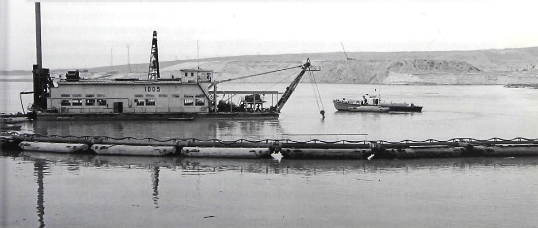
Плавучий земснаряд на строительстве Саратовской ГЭС
