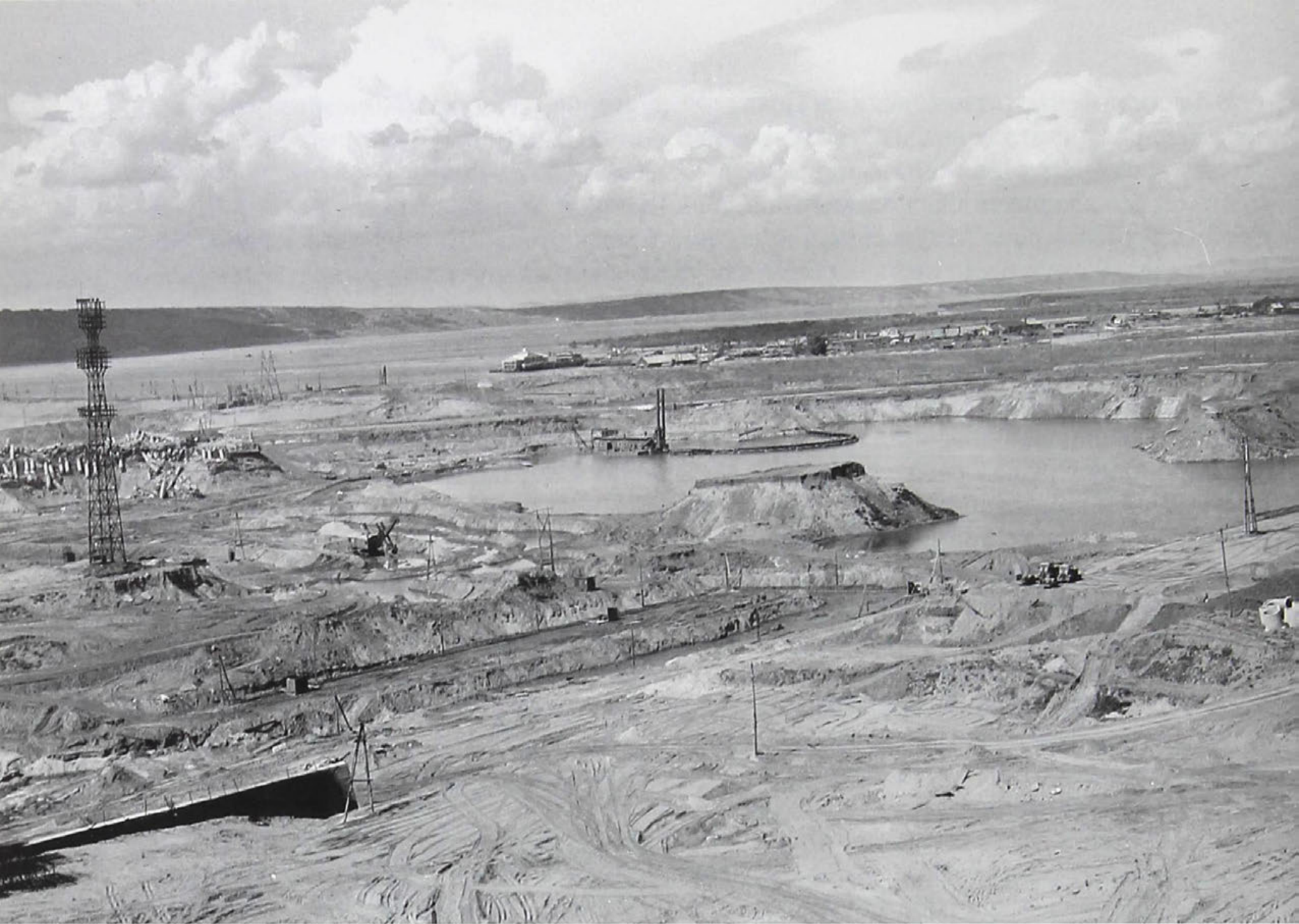
Котлован Саратовской ГЭС
