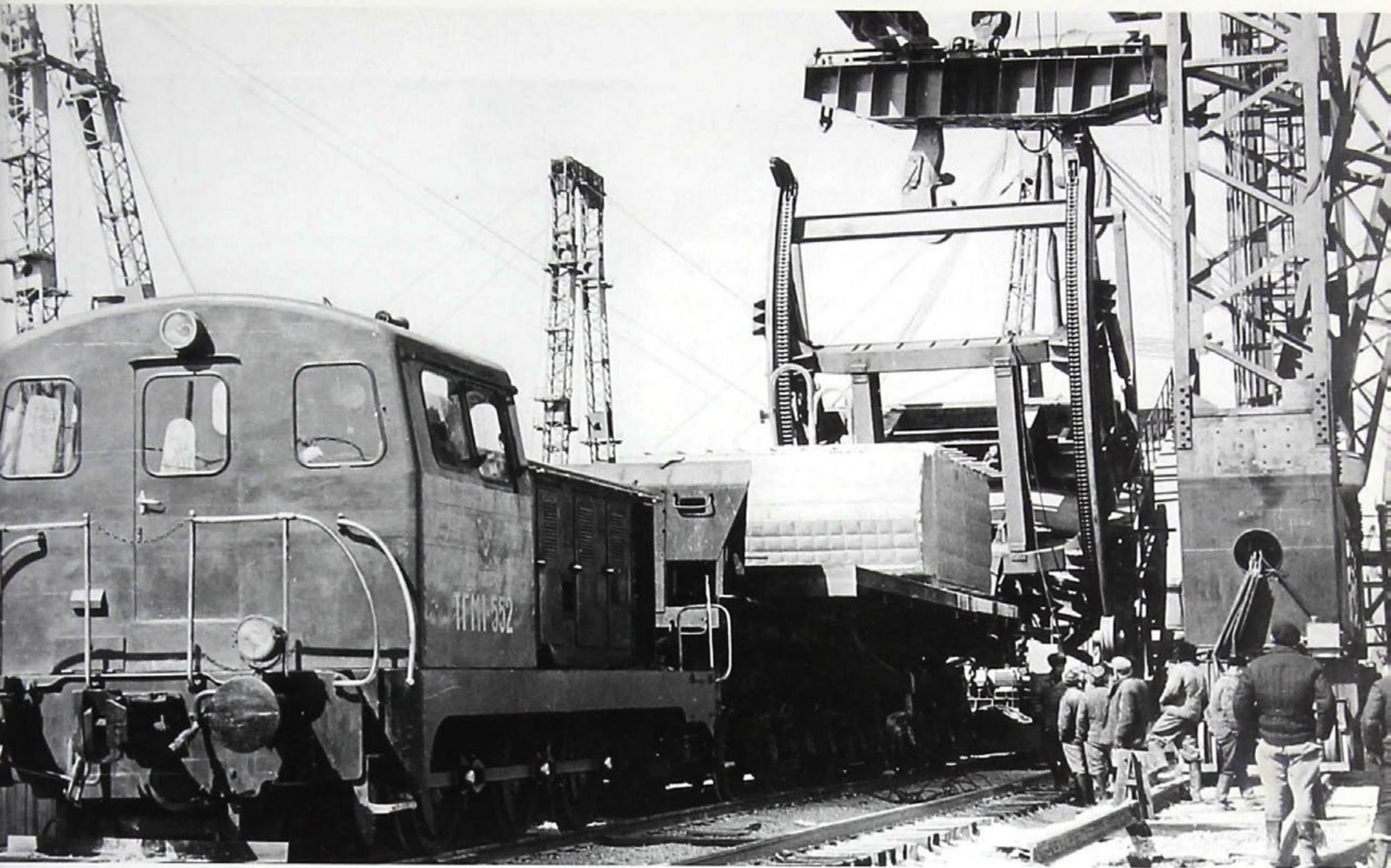
Установка на кантователь первого железобетонного блока
