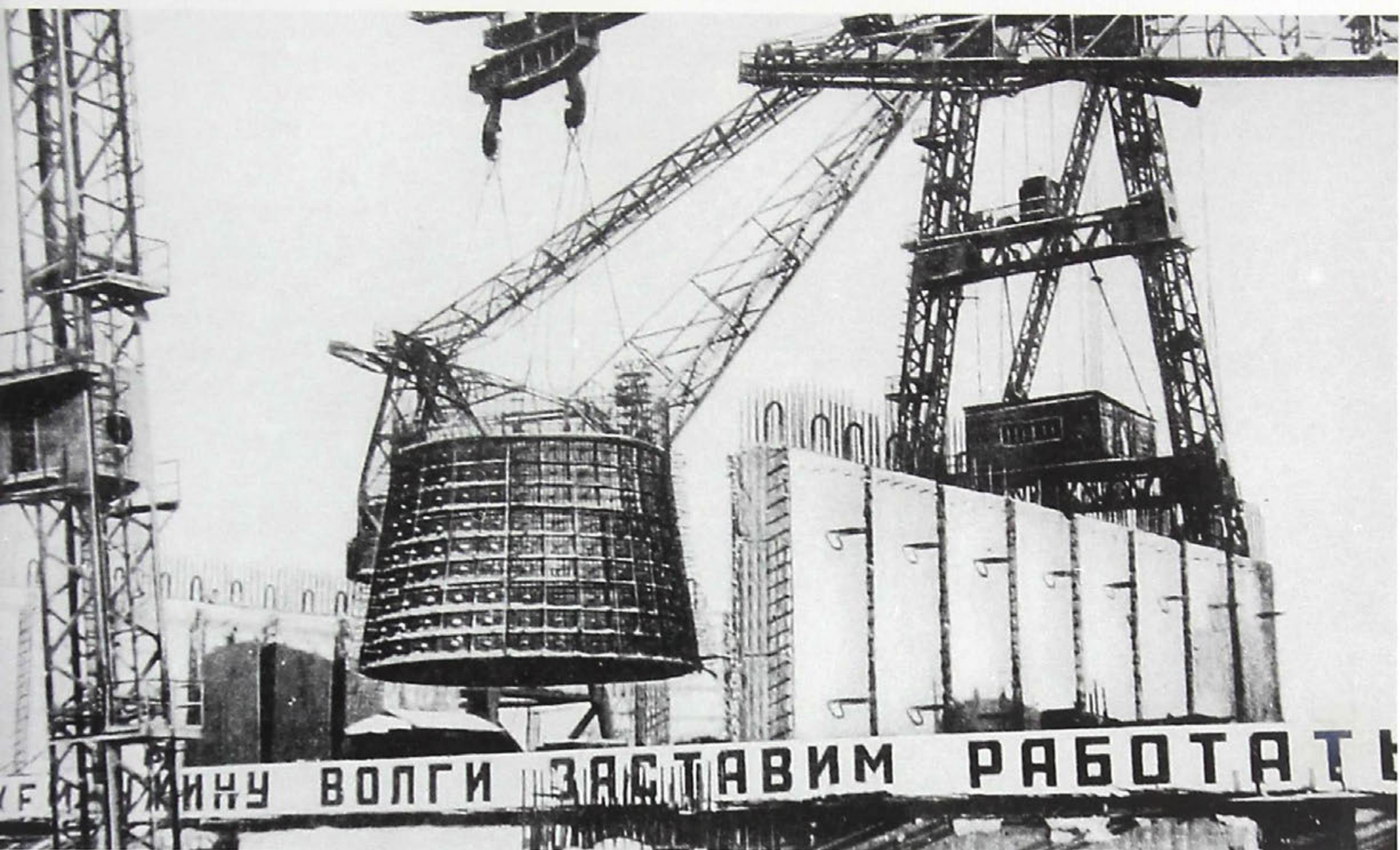
Начало монтажа статоров турбин. Вид со стороны верхнего бьефа. 1966 год
