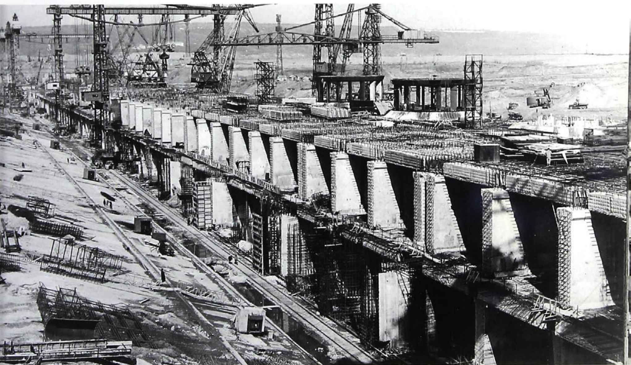
Строится здание гидроэлектростанции
